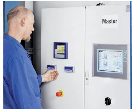
Der Master-Schaltschrank koordiniert die Funktion der einzelnen Anlagenkomponenten.
